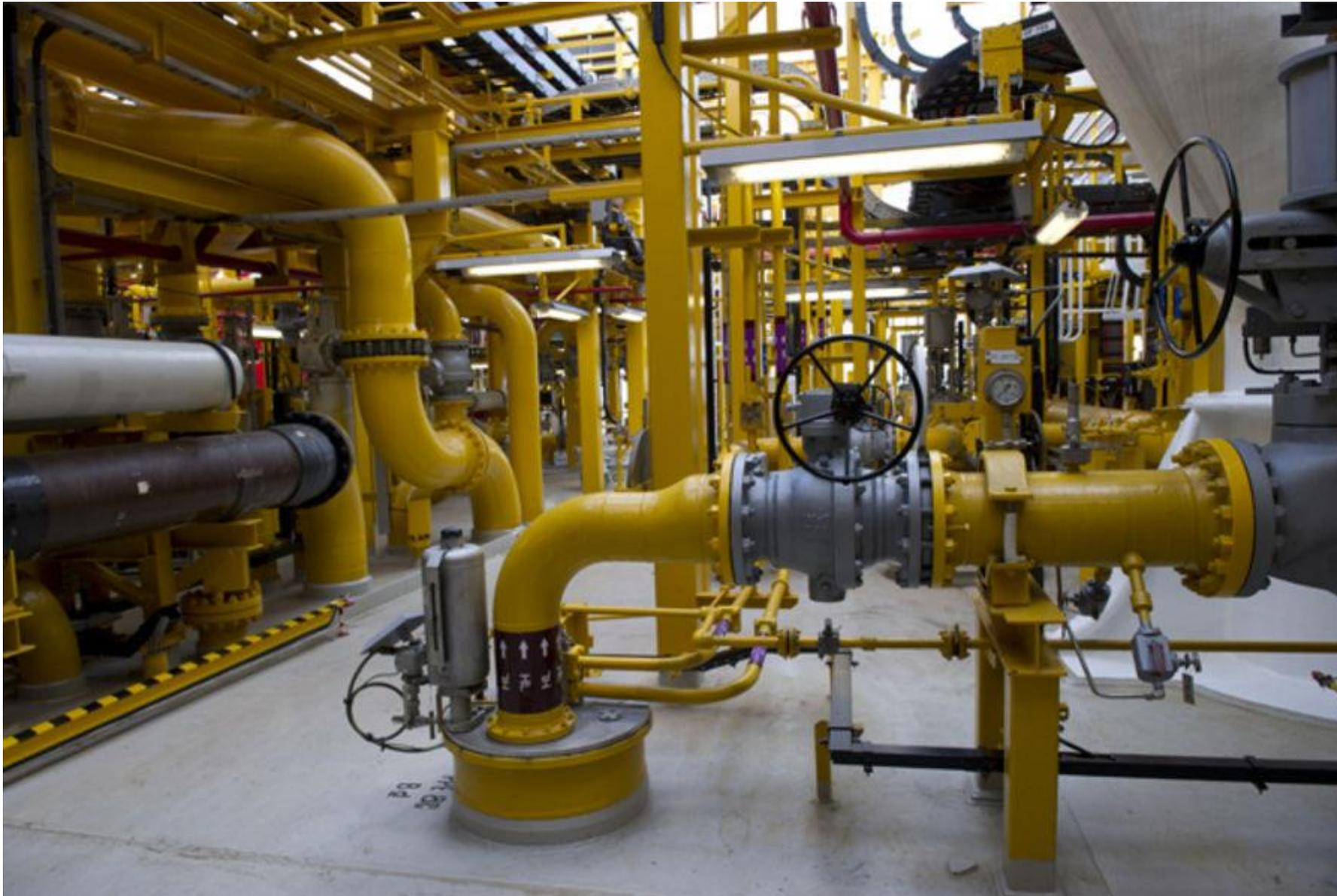
Plus des 3 quarts du bateau sont recouverts d'un enchevêtrement de tuyaux de condenseurs et séparateurs. L'ensemble de l'installation est alimentée en électricité par 5 turbines à gaz de 24 MW, le combustible étant issu directement de la production. La coque permet de stocker jusqu'à environ 1,5 million de barils de pétrole.
